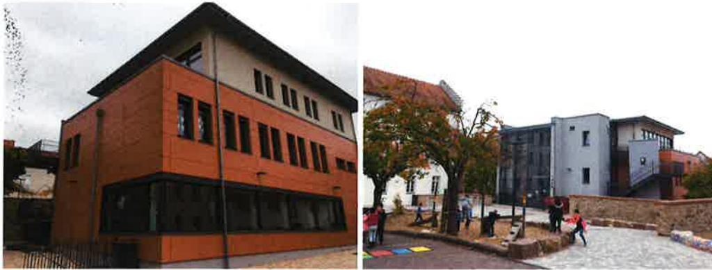
Abbildung 13: Neu gebautes Mehrzweckgebäude der Gemeinsamen Musterschule von der Kleinen Klostersgasse und dem Schulhof an der Augustinergasse aus gesehen
